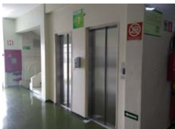
Modernização de dois elevadores de serviços
