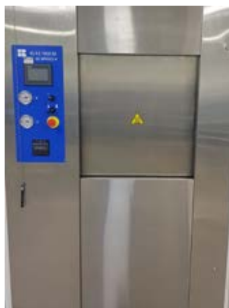
Substituição de autoclave no Centro de Material Esterilizado
