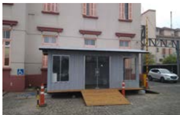
Instalação de contêiner na guarita
