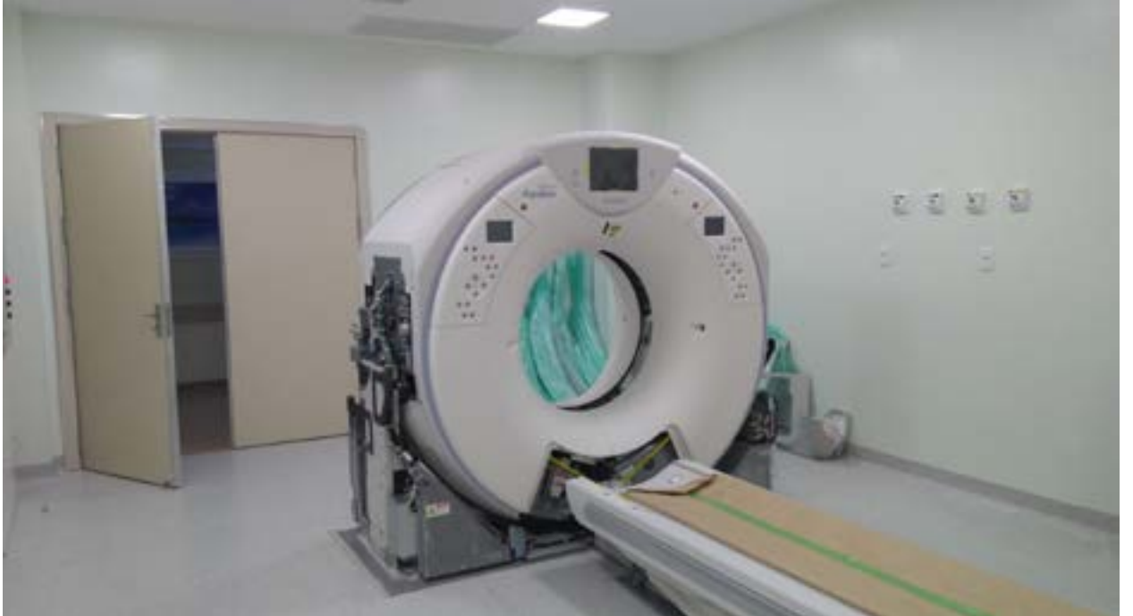
Nova sala para instalação do tomógrafo Canon
